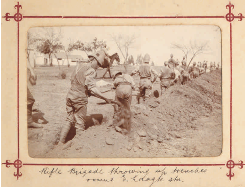
Digging trenches at Elandslaagte
